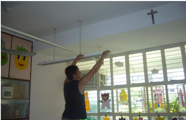
更換 T8 轉 T5 替換型節能熒光燈套裝
