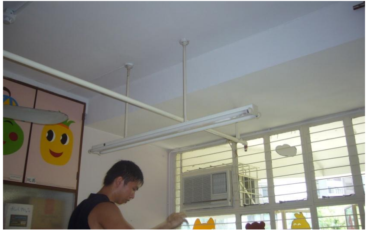
更換 T8 轉 T5 替換型節能熒光燈套裝
